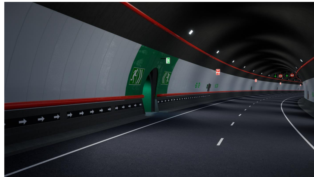
Figura 1: Interior de un túnel principal
